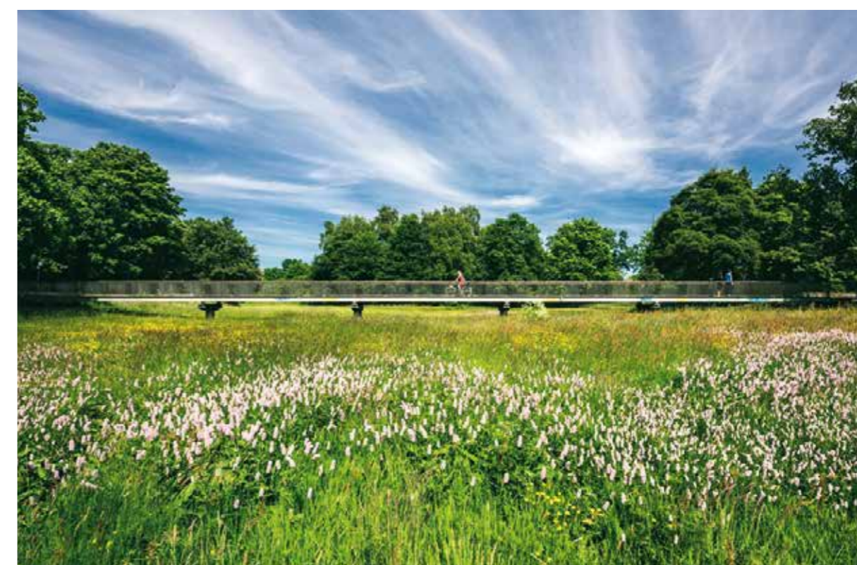
Abbildung: Brücke Luhewiesen
